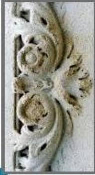
Elle provoque des **dommages mécaniques** lorsqu'elle est projetée sous pression sur une pierre endommagée.
