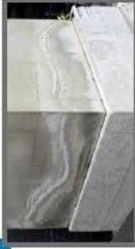
Elle transporte les sels minéraux dans les pores de la pierre, puis les dépose sous forme d'**efflorescences** lorsqu'elle s'évapore.
