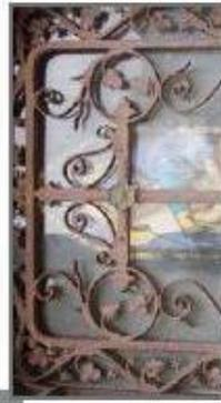
**Les métaux** : essentiellement les ferreux (fer forgé, fonte), les cuivreux (bronze et laiton) et parfois le plomb pour les scellements.
